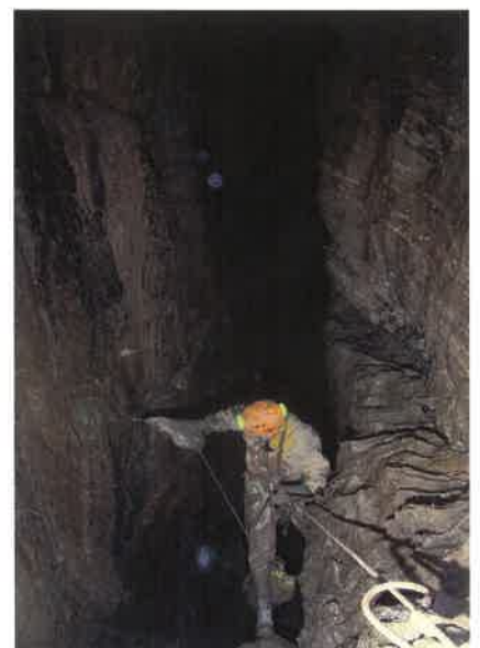
Figure 32 - Brochage dans la cheminée Arrosée. Photo J.-C. London.
