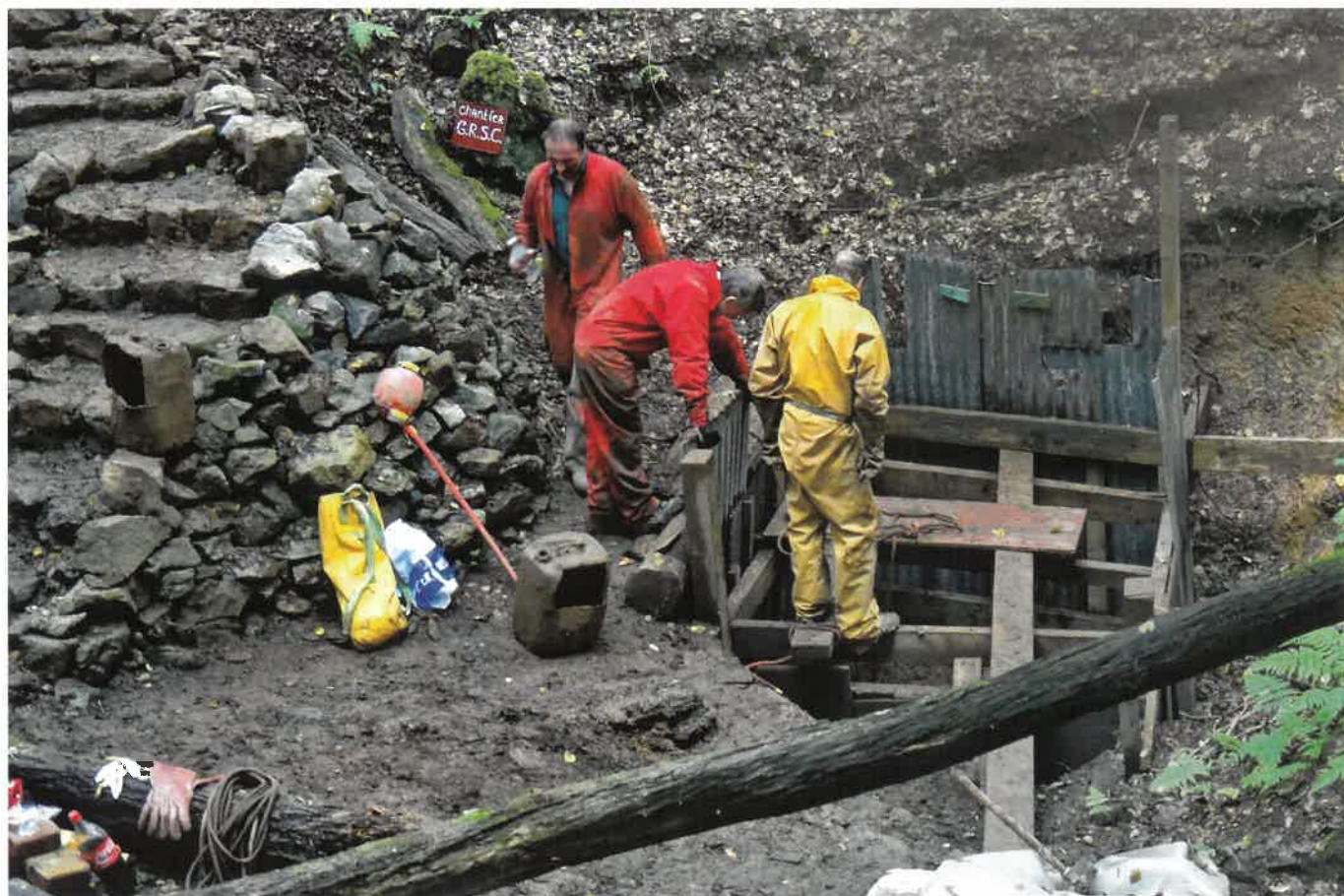
Figure 83 - Nouveau chantier FD6. Photo P. Dumoulin.
